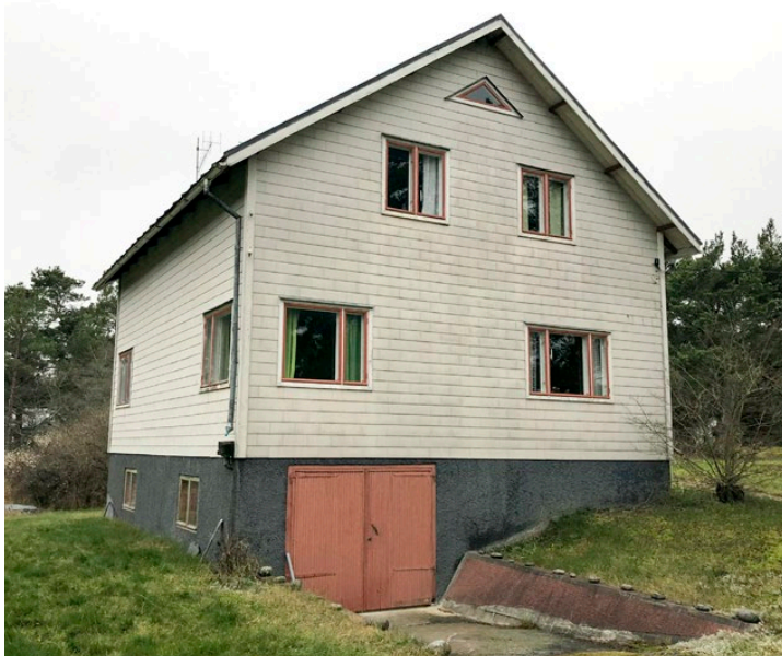
Husfasaden före renoveringen.
